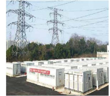
电网侧储能应用可参与调频、调峰、电压稳定、黑启动等电力市场辅助服务,获得相应的收益,同时可以提升电网利用率,通过调节电网峰谷差,延缓配电网扩容。在电网发生停电故障时,能够提供应急电源避免故障修复时电力中断,保证供电可靠性。
