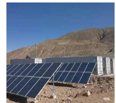
微电网是利用分布式能源、储能装置和可控负荷共同组成的低压网络,容量范围从几百千瓦到几个兆瓦,可平滑接入大电网和独立自治运行,在上一级电网故障时可脱网独立运行,故障恢复后可重新并网。
