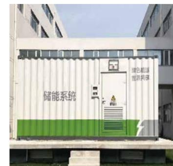
在工商业负荷需求大的厂区园区,储能系统能够帮助用户进行“削峰填谷”,增加经济效益;同时调节各分布式电源和充电桩等灵活充放电,平滑负荷曲线,减少对大电网调峰和容量备用需求,应急保电,构建多层次的电力安全风险防御体系。
